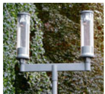
An der Klemensstraße wurden Zylinderleuchten installiert.
